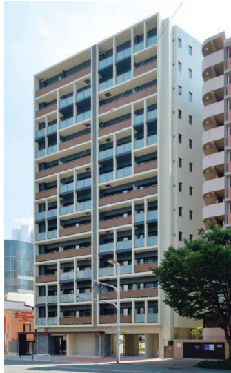
8.31 「ピエネスタ千代県庁口」竣工
