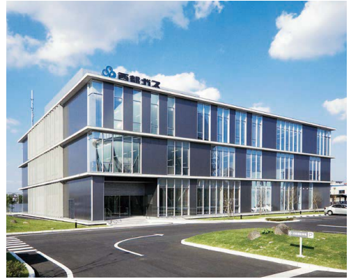
8.22 「ニシコービル熊本」竣工
