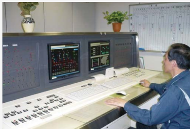
建築物の保全運転・維持管理
