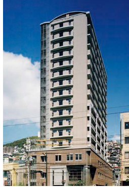
4.16 「ニシコービル御船蔵」 竣工
