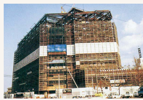
1987年 パピヨン24 建設中
