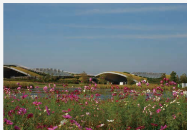
土木・外構工事
