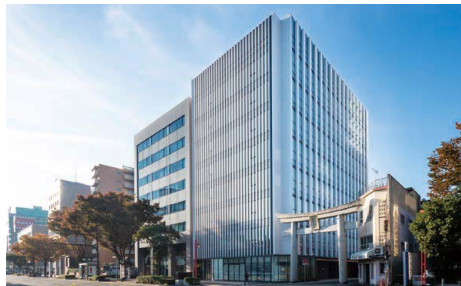
11.15 「博多祇園NKビル」竣工
