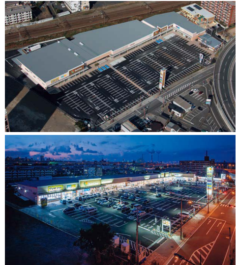
1.9 「サンリブ西小倉」竣工
