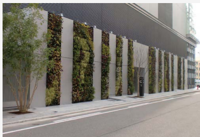
造園・緑化工事
